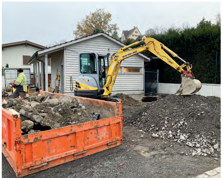
Die Bauarbeiten für die Erweiterung des Klubhauses beim Segelbootshafen Hintermeggen sind angelaufen.
